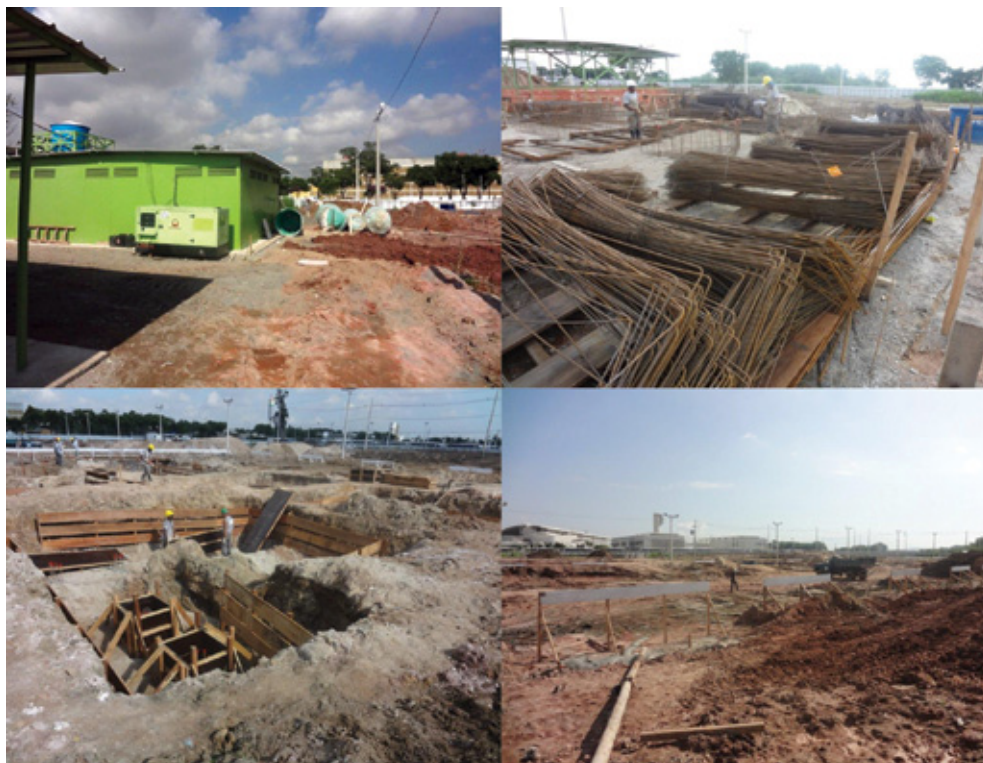
Canteiro de obras do Ladetec – 2ª etapa
