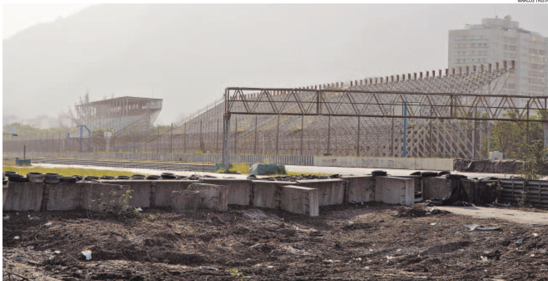
Última volta. Futuro palco do Parque Olímpico, o antigo Autódromo Nelson Piquet, em Jacarepaguá, já está com parte de sua arquibancada demolida. Derrubada termina em julho
