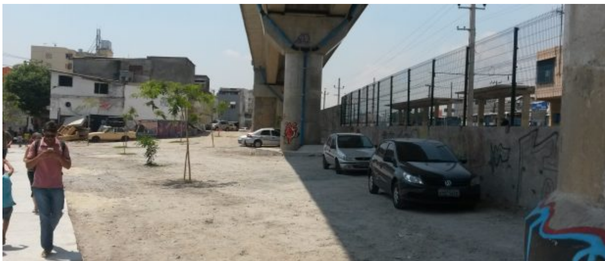
Área abandonada após as obras, sem funcionalidade urbana.
