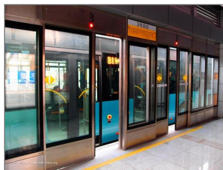
Mecanismo robusto de portas deslizantes no BRT de Lanzhou, China Foto: ITDP
