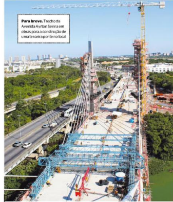
Futuro. Ponte Estaiada sobre a Lagoa de Maracanã por onde passará a Linha 4 do Metrô
