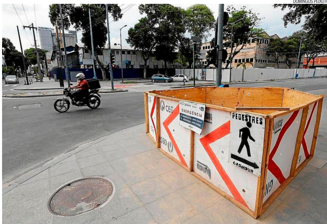
Obras. Intervenções como a da CEG, na esquina da Barão de Tefé com a Av. Venezuela, no Porto, serão aceleradas
