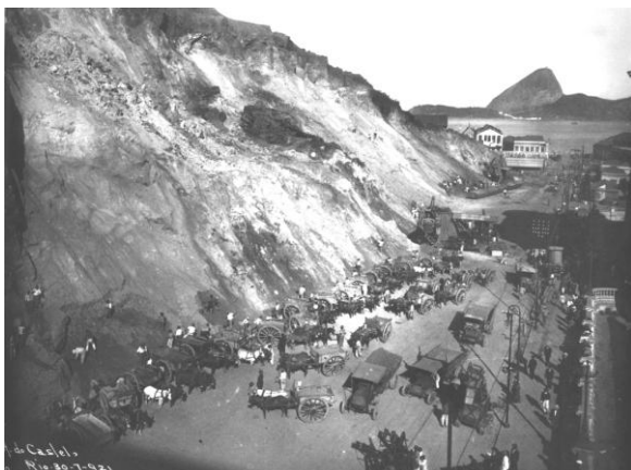
Figura 05: Desmorte do Morro do Castelo
