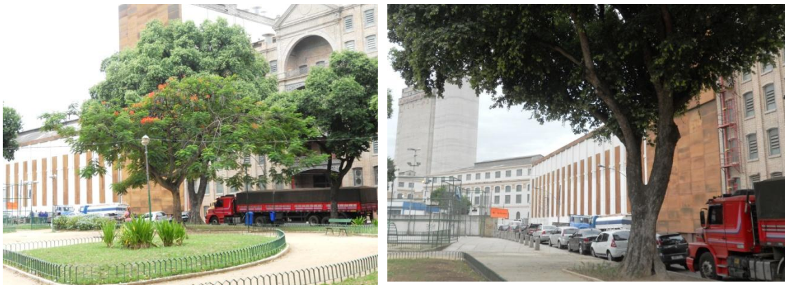
Novo tratamento da fachada do prédio do Moinho Fluminense – Fotos Leonardo M de Mesentier
