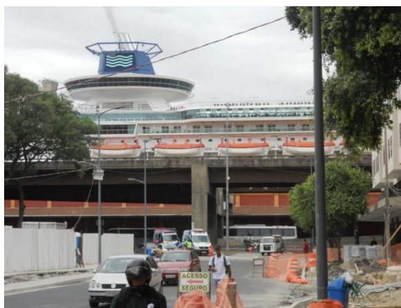
Vista da Av. Barão de Tefé
