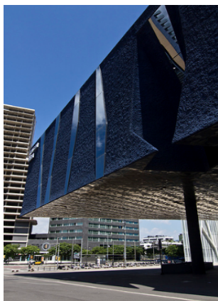
Figura 10 – Fachada - edifício BLAU Fonte: Acervo pessoal, 2013.
