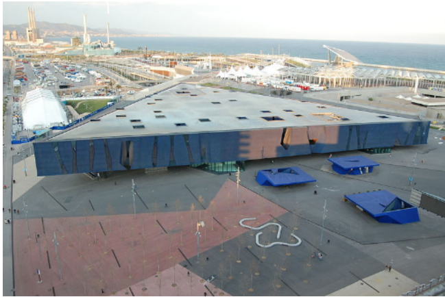
Figura 08 - Edifício Fórum e as clarabóias. Fonte: ILESH, 2007 (Wikimedia Commons).
