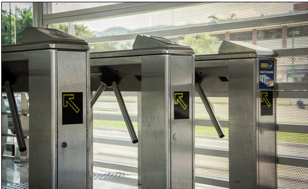
Figura 4.9 – Catracas eletrônicas para controle da tarifa antes do embarque (BRT RIO, 2014).
