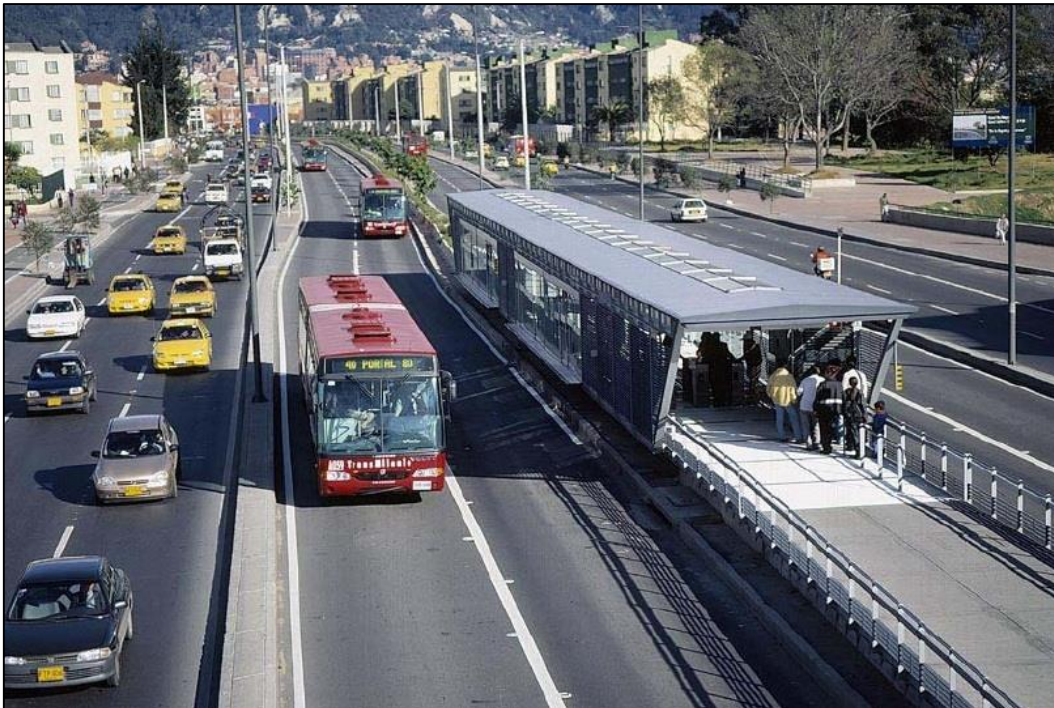
Figura 4.1 – Sistema BRT TransMilenio em Bogotá, na Colômbia (MINISTÉRIO DAS CIDADES/ITDP, 2008).
