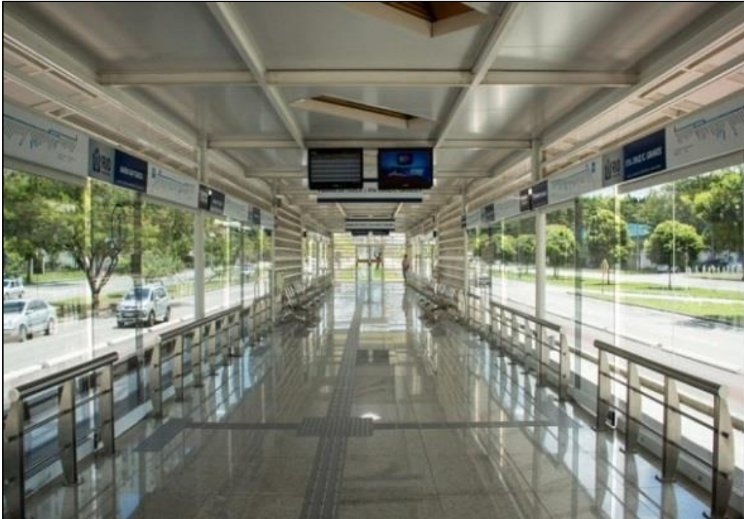
Figura 4.8 – Estação abrigada com painéis eletrônicos para informações dos horários de chegada dos ônibus (BRT RIO, 2014).
