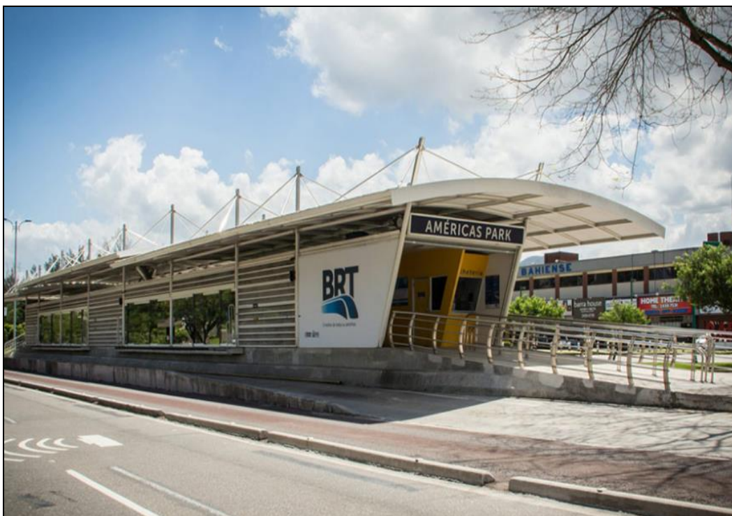
Figura 4.6 – Estação América Park do BRT Transoeste, posicionada no canteiro central da Avenida das Américas, no bairro da Barra da Tijuca. Em amarelo, verifica-se a cabine para compras de bilhete (BRT RIO, 2014).
