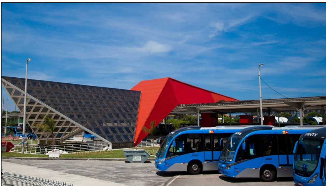
Figura 4.11 – Terminal Alvorada, no Bairro da Barra da Tijuca (CIDADE OLÍMPICA, 2014).
