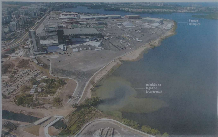
Área de poluição mais densa na lagoa de Jacarepaguá, cuja licitação para drenagem foi suspensa por suspeita de cartel; logo atrás, o Parque Olímpico
