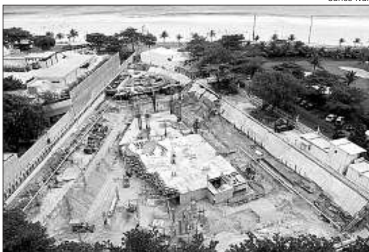
O TERRENO desmembrado do hotel para as obras do novo prédio
