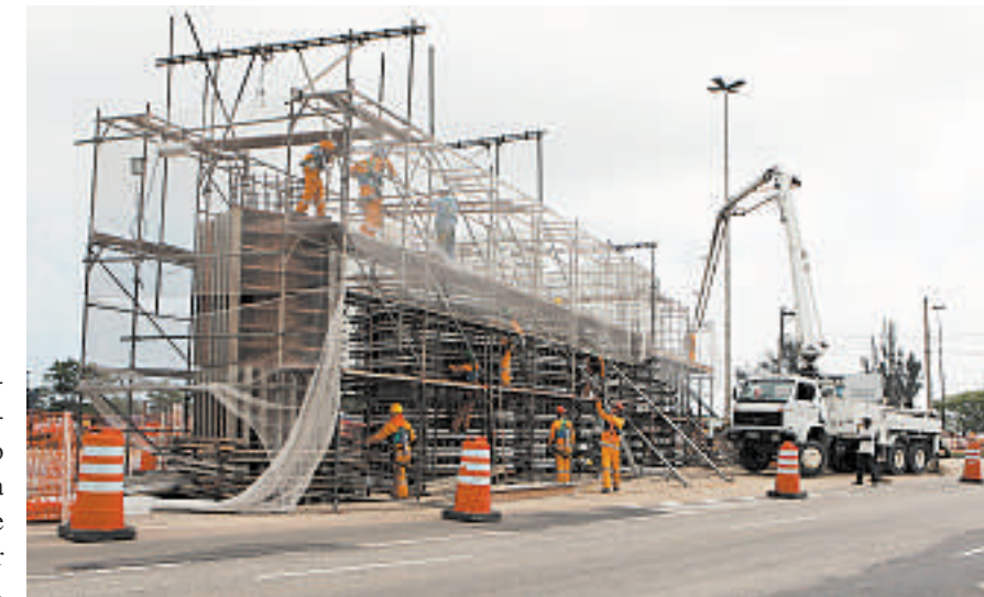
A estrutura do viaduto que começa a ser erguido no cruzamento das avenidas das Américas e Salvador Allende, parte do projeto do BRT Transoeste
