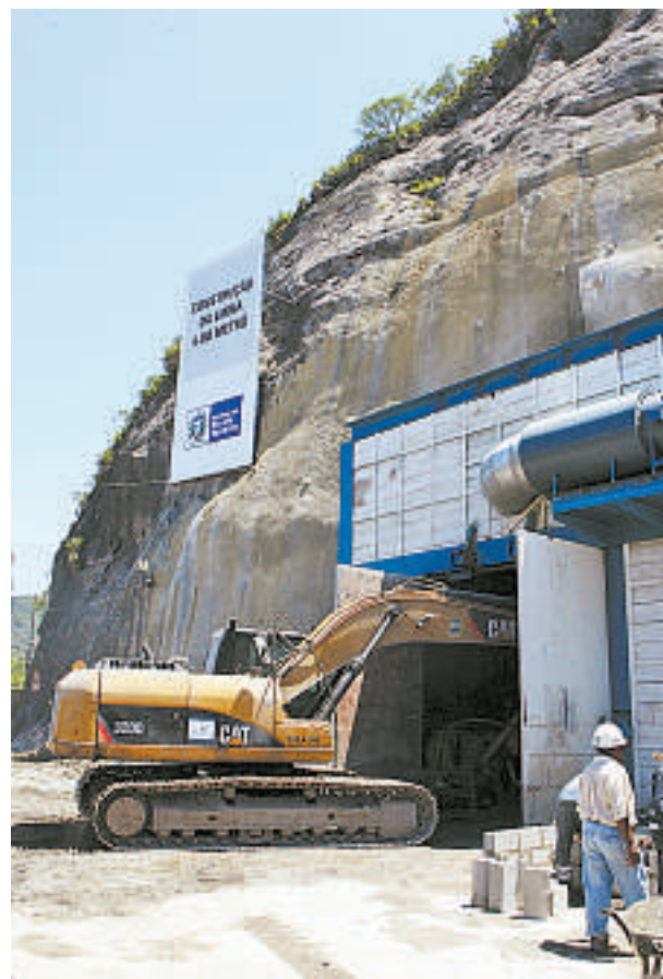
As escavações do túnel de serviço da Linha 4 do metrô, na Barra: pouco a pouco, as máquinas avançam por dentro da Pedra do Focinho do Cavalo, que faz parte do Maciço da Tijuca, em direção à Zona Sul (fotos do alto)
