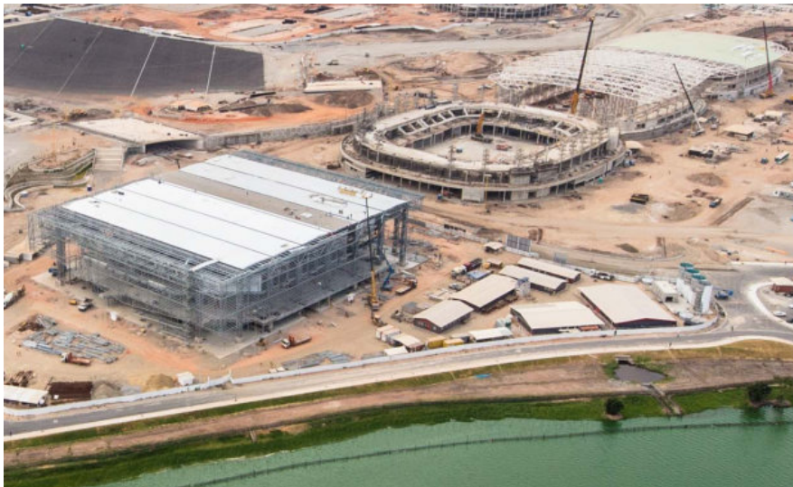
Obras no Parque Olímpico, em Jacarepaguá, no final de dezembro de 2014 (Foto: Rio Cidade Olímpica)
