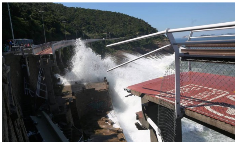
Ressaca derruba parte da ciclovia da Avenida Niemeyer - Custódio Coimbra / O Globo
