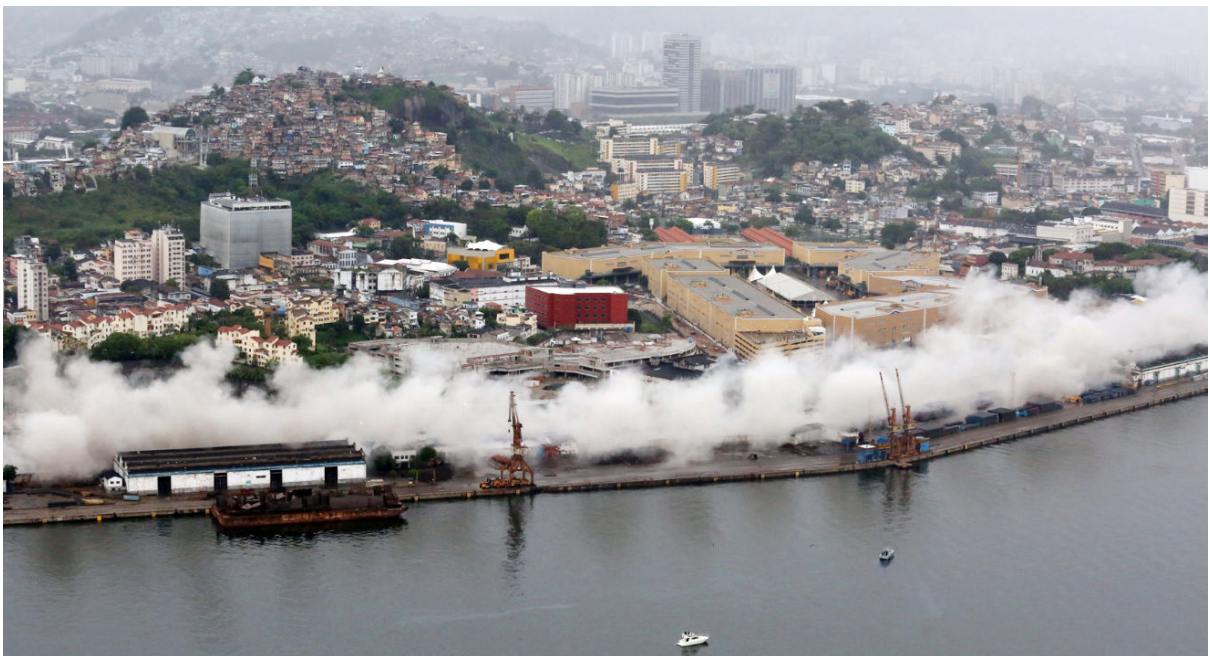
Figura 11: a implosão do Elevado da Perimetral em 24/11/2013 – Fonte: Portal G1
