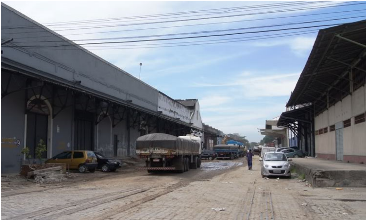
Figura 4: a degradação e o abandono da Via Trilhos
