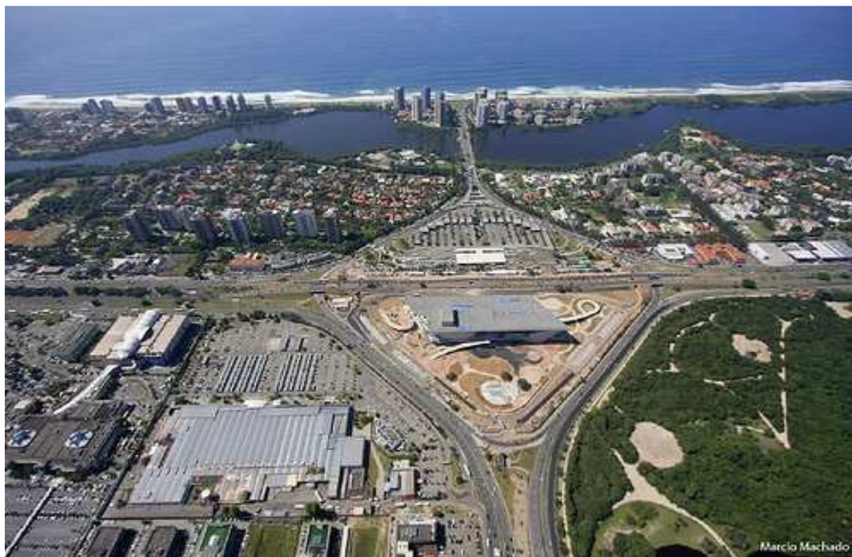
Figura 14: Cidade da Música - Vista Aérea. Fonte: Márcio Machado.
