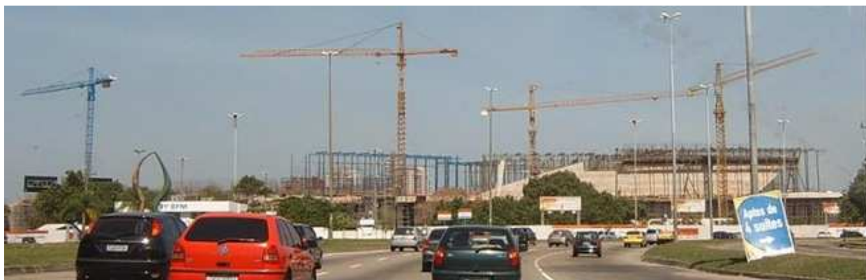
Figura 24: Cidade da Música - Obra.
