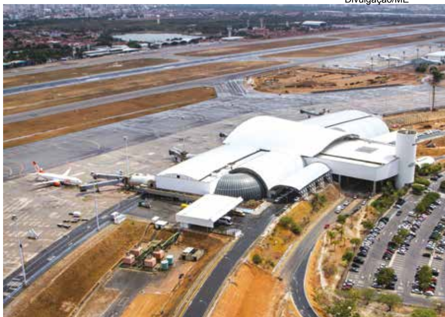
Obra de ampliação do aeroporto de Fortaleza
