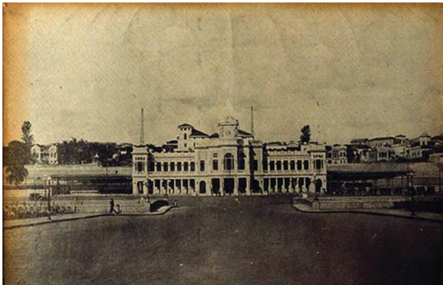
Figura 2 – Vista do prédio da Estação, a partir do eixo da antiga Av. do Comércio (hoje Av. Santos Dumont). Inaugurado em 1922
